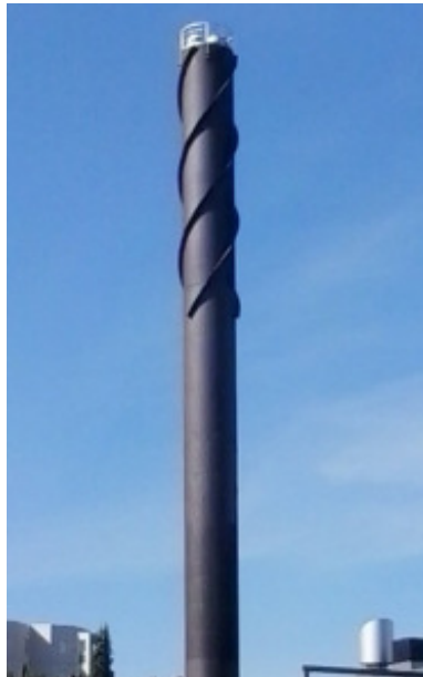
Figura 21: elemento a spirale posto sulla superficie di una ciminiera per la distruzione della coerenza nel distacco dei vortici nel caso di scia di Kármán.
